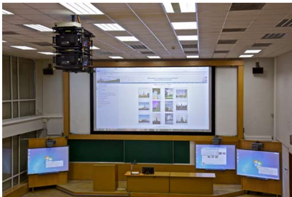
Рис. 3. Спаренные проекторы для вывода 3D-изображения (МГУ)
